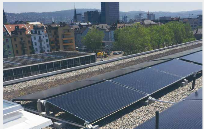
So sieht die Solaranlage auf dem Dach der Siedlung Erikastrasse aus.
