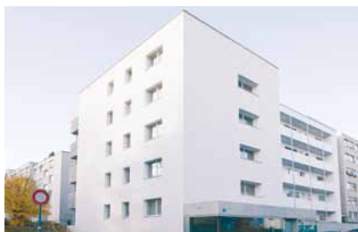
Kreis 9 Siedlung Feldblume Totalsanierung 2009 bis 2010
