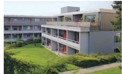
Kreis 6 Siedlung Irchel Sanierung und Aufstockung 2004 bis 2008
