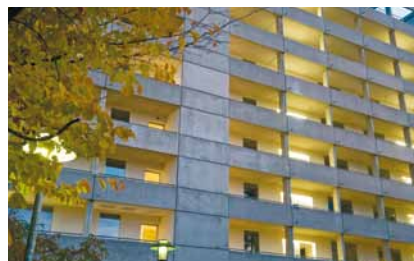
Kreis 9 Siedlung Grünau Sanierung 2009 bis 2010
