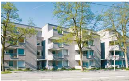
Kreis 7 Siedlung Gladbachstrasse Totalsanierung mit Aufstockung 2007 bis 2008
