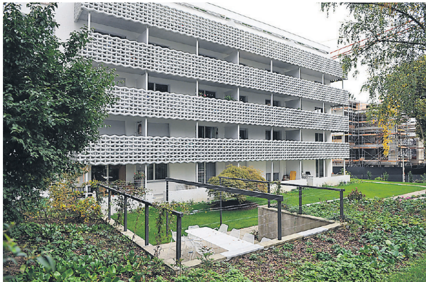
Die Rückfassade mit den neuen, von aussen blickdichten Balkonen.
