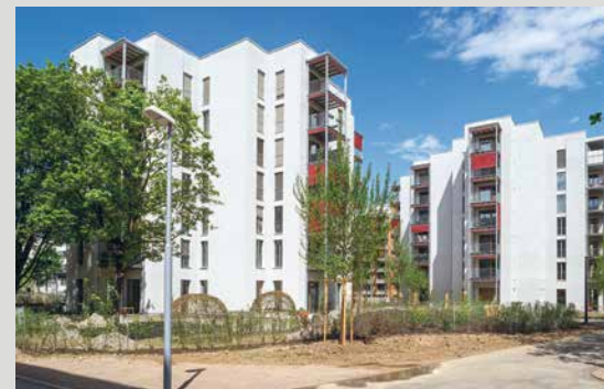
Im Frühling 2018 konnten die ersten zwei Gebäude der Ersatzüberbauung Helen Keller in Schwamendingen bezogen werden. Zwei weitere Gebäude sind noch im Bau.
