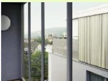
**Material- und Farbkonzept** › Die Aufstockung und die viergeschossige Erweiterung an der Möhrlistrasse 108 sind in vorfabriziertem Holzelementbau realisiert. Die Holzverkleidung der Frontseiten und der Seitenfassaden besteht aus vertikalen Zedern-Lamellen. Die vorgesetzten, skelettartigen Betonstrukturen der Balkone und die rückseitigen Laubengänge sind in einem hellen Grauton gehalten. Sie bilden einen Kontrast zum dunkleren Grau der eigentlichen massigen Gebäudevolumen mit den Wohnräumen.
