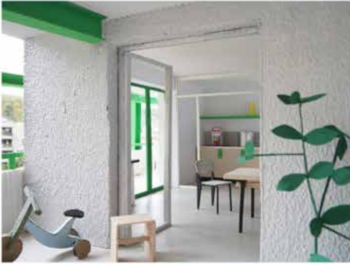
Das vorgelagerte Stahlgerüst bringt neue Qualitäten in die Bestandswohnungen des Turms.
