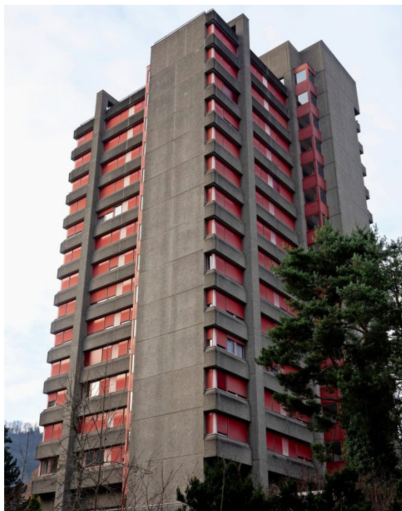
Dieses Hochhaus in Zürich Leimbach muss saniert werden.
