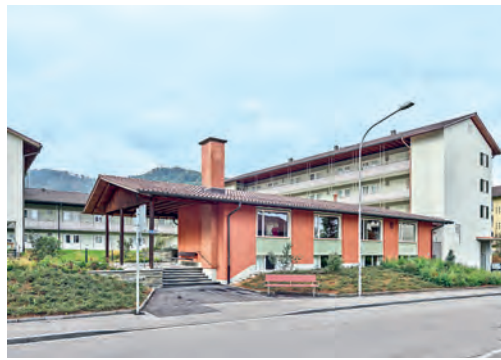
Der Pavillon mit Cheminée ist Siedlungstreffpunkt.
