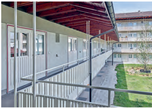
Laubengänge erschliessen die 53 Kleinwohnungen.
